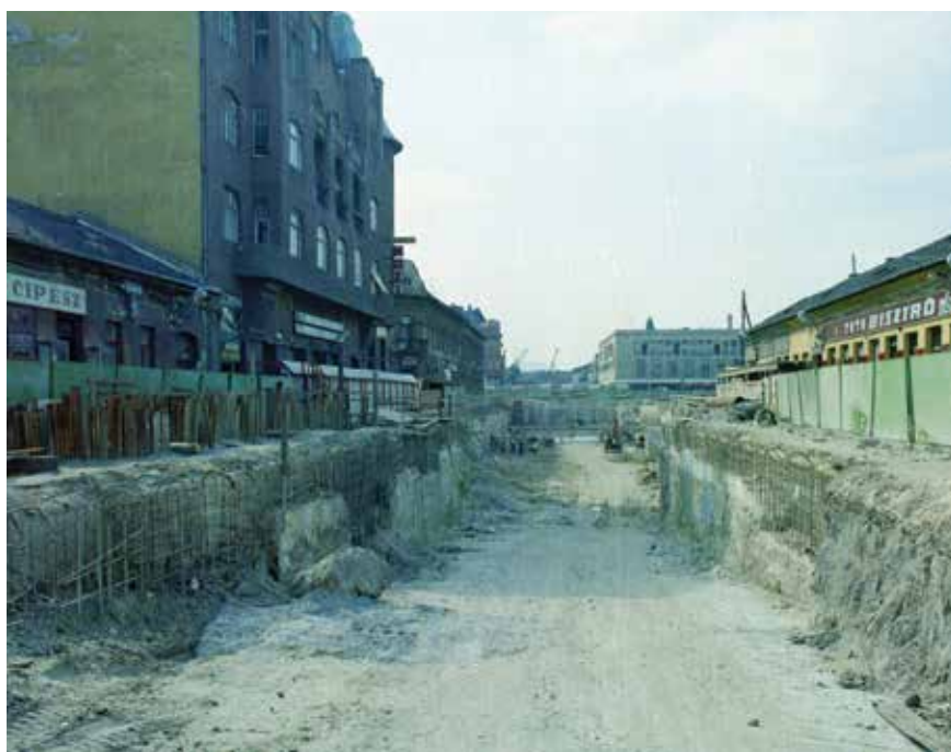
Az Árpád út a Lebstűck Mária utca felől, az István (Bajcsy-Zsilinszky) út felé nézve, a metró építési területe, 1987 (Forrás: Fortepan)
